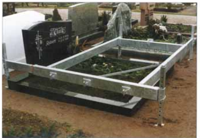
Der Grundrahmen ist gelegt. Abstützfüße längsseitig ausgezogen.
